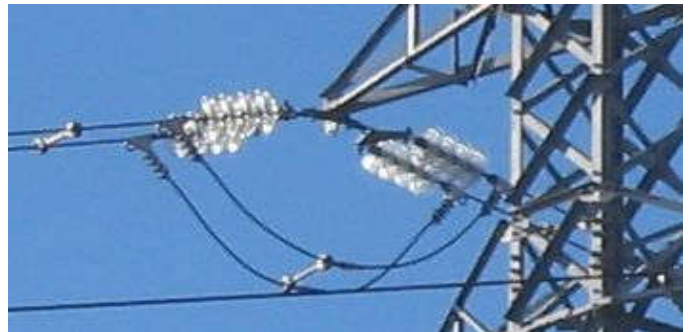
Fig. 1.16. Aisladores usados en un tendido de red eléctrica
